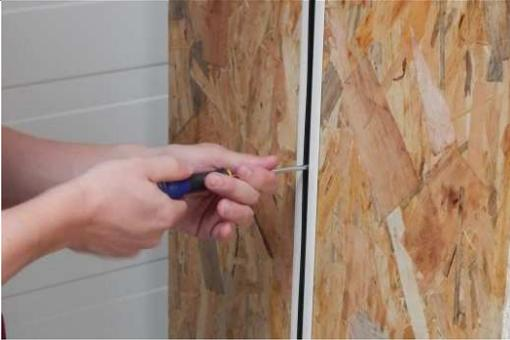
16. Nach dem Einsetzen der Unterputzführungsschiene in das Montageprofil ist dieses mit Blechschrauben/Schrauben fest am Montageprofil zu befestigen. Zeich. 4
