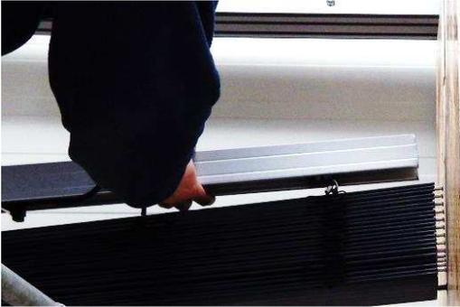
8. Setzen Sie das Paket mit den Führungsbolzen in das Montageprofil (Zur Vereinfachung empfiehlt es sich das Paket etwas schräg zu stellen, um die Führungsbolzen nicht an der Fensternische zu beschädigen).
