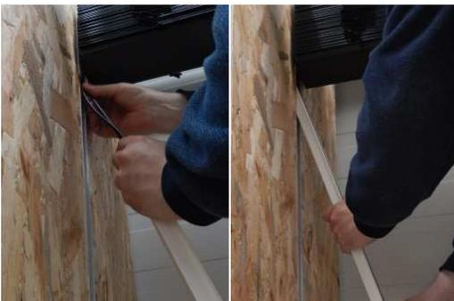
15. Führen Sie die herausragenden Stücke der Dichtungen in das montierte Teilstück und setzen die Unterputzführungsschiene in das Montageprofil
