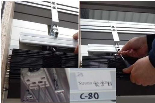
10. Schieben Sie das Paket hoch, um die Oberschiene in den Schienenhaltern zu befestigen. Achten Sie darauf, dass die Führungsbolzen in der Führungsschiene richtig eingeführt sind.
