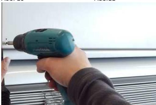
16. Bringen Sie die vordere Blende an den Blendenhilfshaltern an. Abb. 12
