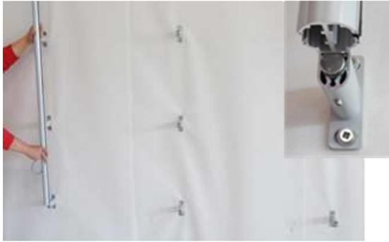
12. Schieben sie die Führungsschiene über die Metallzapfen, richten sie aus und ziehen die Inbusschrauben fest. Montieren sie anschließend die nächsten Führungsschienen.
