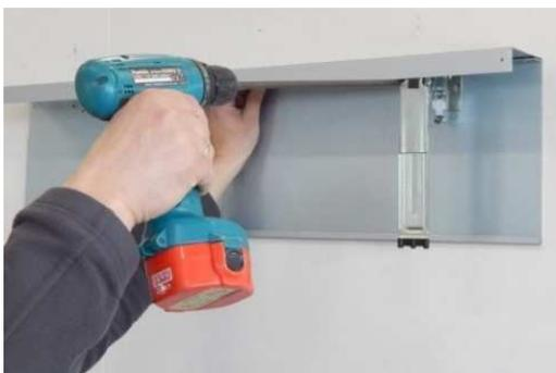
1. Montieren sie die Oberschienehalter mit Federmechanismus an die Montagebügel. Die zusammengeschrabten Halter der Blendenhöhe anpassen und festschrauben.
