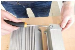
1. Bringen Sie den Seilhalter provisorisch an der Oberschiene an, so dass eine spätere Einstellung noch möglich ist.
