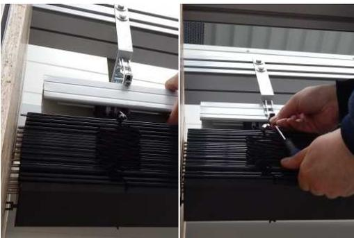
10. Lösen sie die Schraube am Halter soweit, dass sich der Halter öffnen lässt
