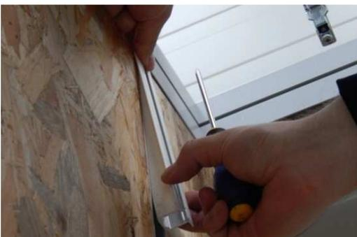
7. Bringen Sie das abgeschnittene Stück bspw. mit Hilfe von Blechschrauben oben im Montageprofil fest an (Zeichn. 5). Die Schraubenköpfe dürfen dabei die Führungsbolzen der Lamellen nicht behindern. Führen Sie dies auf beiden Seiten durch.
