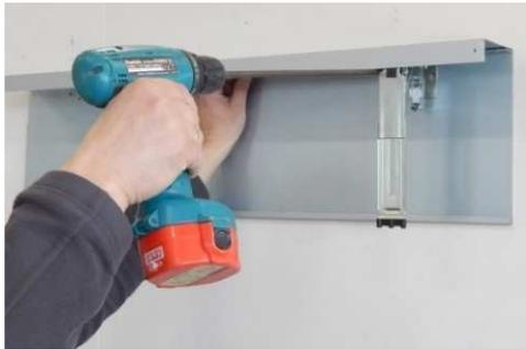
1. Montieren sie die Oberschienenhalter mit Federmechanismus an die Montagebügel. Die zusammengeschraubten Halter der Blendenhöhe anpassen und festschrauben.
