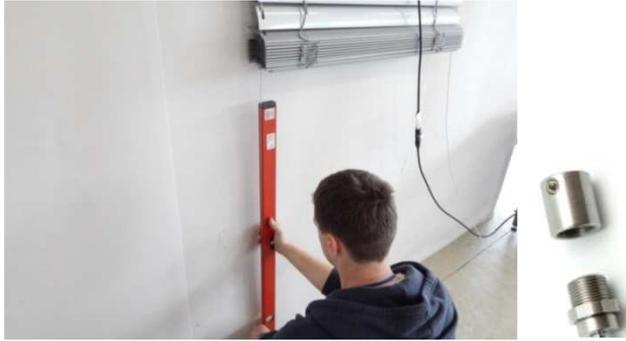
5. Mit Hilfe der Wasserwaage markieren Sie die Position des Spannwinkels (bei Fassadenspannern) oder des Bodenspanners. Dieser muss im Lot zur Seilführung angebracht werden.
