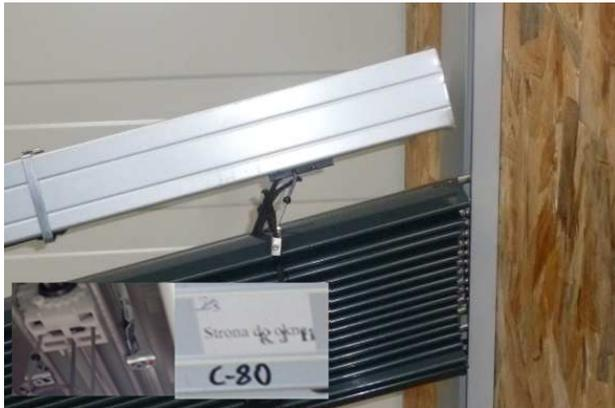
8. Lösen Sie die Schrauben der Oberschienenhalter, so dass sich die Halter öffnen lassen.
