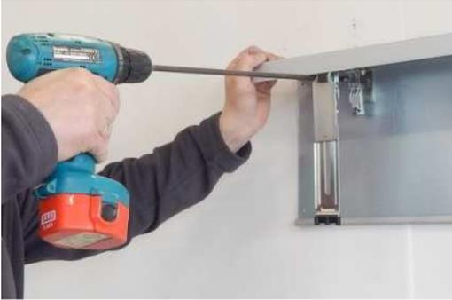
2. Bringen Sie die Halter mit Blenden, mit geeignetem Befestigungsmaterial an der Wand oder in der Nische an.
