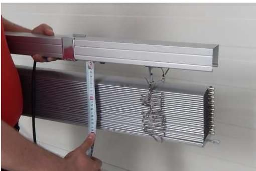
5. Messen Sie die Höhe von der Unterkante der Oberschiene bis zur Unterkante des Fallprofils aus (bei geschlossenem Paket).
