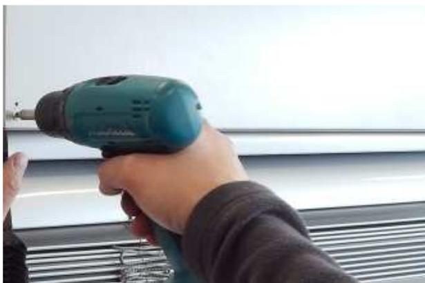
17. Montieren Sie den Revisionsteil an der Unterputzkassette und sichern ihn mit Schrauben.
