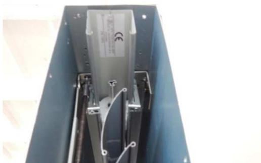
1. Montieren sie die Oberschienehalter mit Federmechanismus an die Montagebügel.
