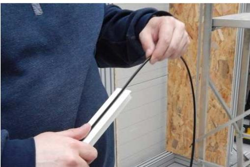
13. Bereiten Sie das Reststück der Unterputzschiene zur Montage im Montagprofil vor (Bohren Sie die Löcher für die Schrauben in der Unterputzführungsschiene vor).
