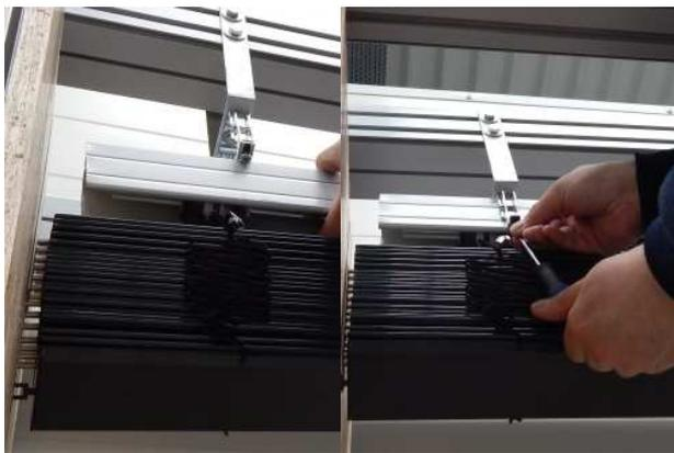
10. Heben sie das Raffstorepaket nach oben, um die Oberschiene in den Schienenhaltern montieren zu können.
