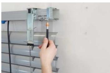
4. Positionieren Sie den Seilhalter so auf der Oberschiene, dass das Seil die Kanten der ovalen Löcher in den Lamellen nicht berührt, und ziehen die Schrauben fest
