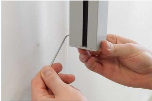
17. Nachdem das Paket in der Kassette montiert wurde, können die unteren Endkappen an den Führungsschienen angebracht werden. (Abb.28)
