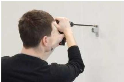
2. Bringen sie alle Halter an den vorher bestimmten Positionen an. Die Anzahl der Halter ist abhängig von der Systemgröße (Abb. 2 – 8). Überprüfen sie während der Montage ständig, ob die Halter exakt senk- und waagrecht montiert sind und führen ggf. Nachbesserungen durch.
