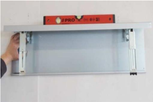
4. Prüfen sie, ob die Blende und die Halter waagrecht ausgerichtet sind und führen sie falls nötig Anpassungen durch. Eine waagerechte Ausrichtung ist für die einwandfreie Funktion des Systems Voraussetzung.
