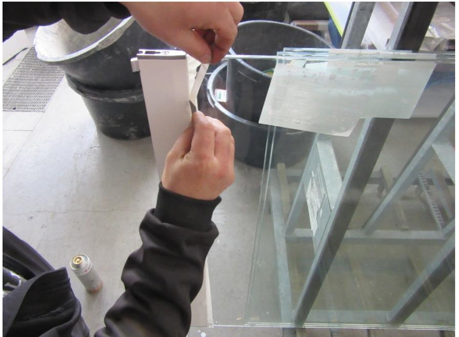
Nun stellen Sie ihre Scheiben auf die Schienen, führen Sie die Scheibe erst oben in die Führungsschiene und dann auf die unteren Schienen.
