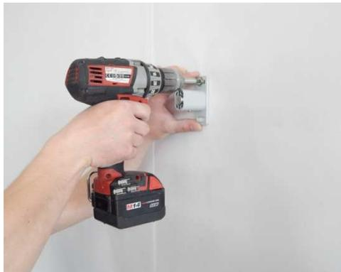
2. Bohren Sie die Löcher und befestigen anschließend die Stahlclips mit entsprechend gewähltem Befestigungsmaterial.
