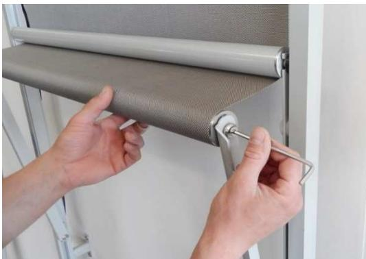
3. Drehen Sie das Fallprofil um eine Umdrehung nach vorne (die Keder im Fallprofil zeigt bei geschlossenem System nach vorne), damit sich der Stoff spannt und schrauben sie den beweglichen Armteil an den Seiten des Fallprofils fest.
