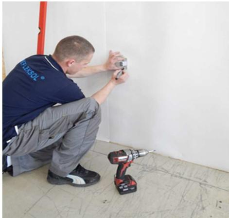
1. Bestimmen Sie Achsposition der Führungsschienehalter am Untergrund. Legen Sie den Halter an und markieren die Bohröffnungen.
