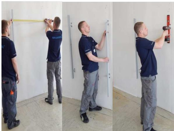
9. Mit Hilfe eines Maßbands und der Wasserwaage übertragen Sie die Maße an die Stelle der Montage der nächsten Führungsschiene.
