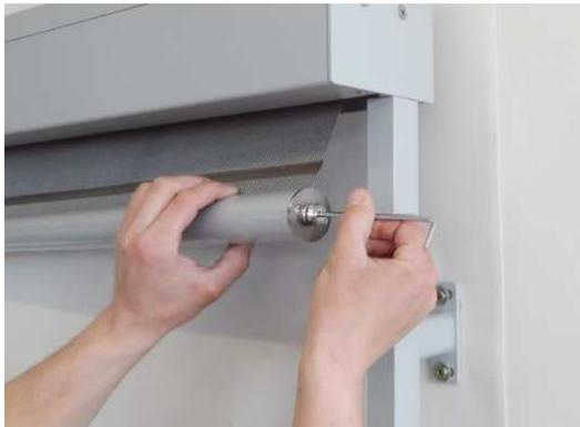
2. Schließen Sie den Antrieb an die Stromversorgung an und fahren den Behang herunter. Anschließend lösen Sie die Schrauben im Fallprofil, um den beweglichen Teil am Fallprofil zu montieren.
