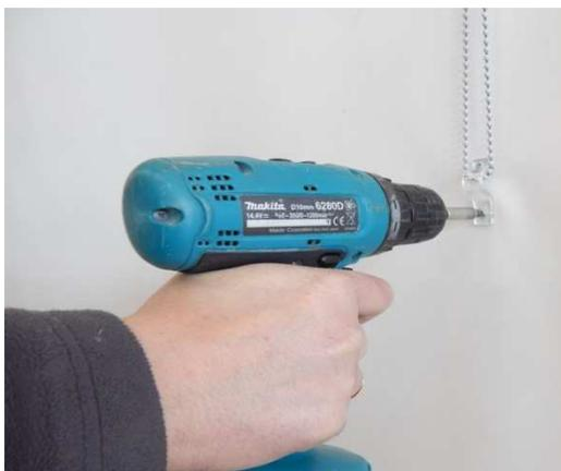
10. Die Kette ist in gespanntem Zustand, durch Anbringen des Kettenzugsicherungs-elements, an der Wand zu befestigen – **min. 150 cm** über dem Boden. Bei Bedarf ist die Länge der Kugelkette anzupassen.
