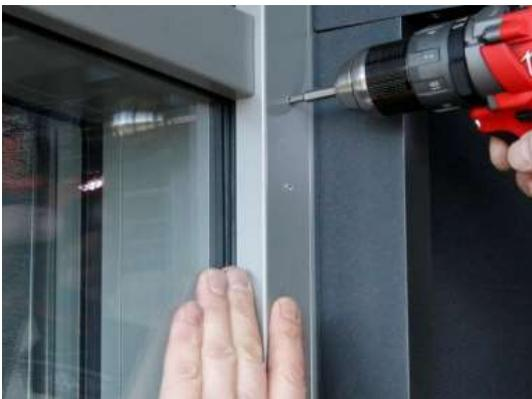
2. Bohren Sie die Löcher für die Schrauben vor, mit denen das System befestigt wird.
