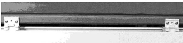
Dann die Oberschutzschiene mit den Seitenkappen in die Halter des Grundprofils so einrasten, dass die Schiene im Plastikhalter gehalten und symmetrisch in der Fenstermitte angebracht werden muss.
