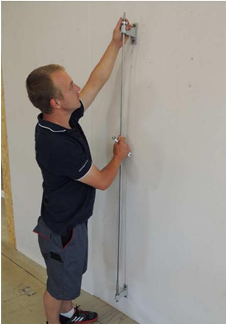
6. Führen Sie die Führungsseile durch die Halter und sichern Sie mittels Metallring und Schrauben.
