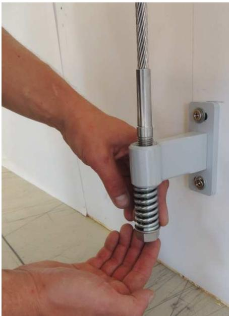
7. Schieben Sie zunächst die Spannfeder über das Seil. Anschließend die Unterlegscheibe und schrauben die Mutter fest.
